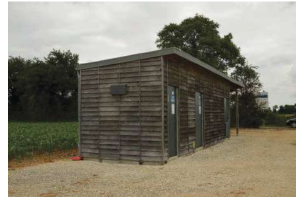
Photographie 104 : Exemple de bardage-bois sur un poste de livraison
