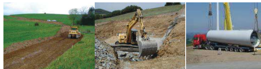
Photographie 89 : illustration d'un chantier éolien.
