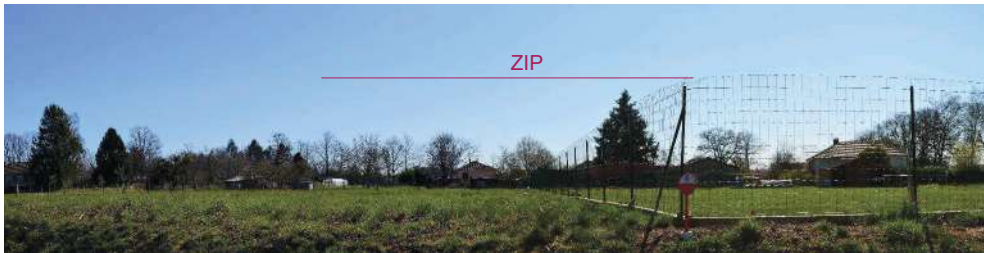
Photographie 71 : Vue en direction de la ZIP depuis la D675, à l'est de Saint-Mathieu
